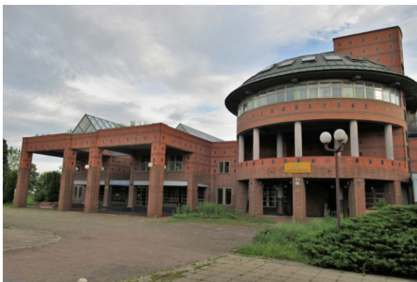
Bizovačke Toplice naj bi zgradili na novo
